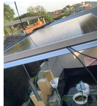
Gambar 4. Hasil Pemasangan Panel surya
