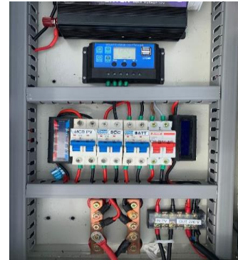
Gambar 3. Rangkaian PLTS pada panel box
