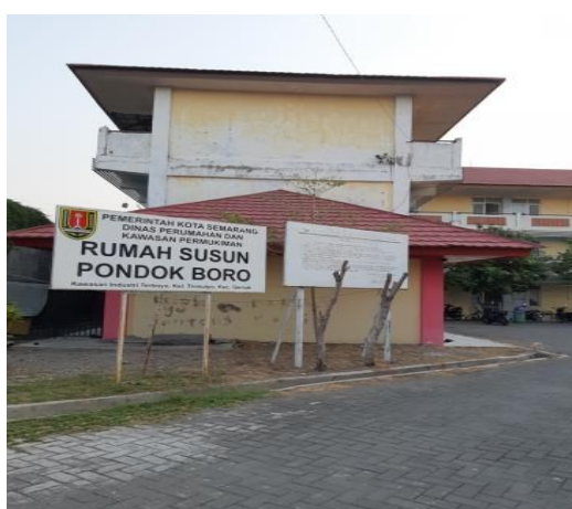
Gambar 2. Bangunan Pondok Boro
